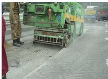
①舗装の切削
