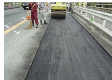
⑨橋面防水及び舗装復旧
